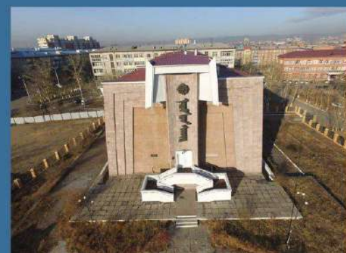
Здание Центра восточных рукописей и килографов ИМБТ СО РАН. Введено в эксплуатацию в 1994 г.
